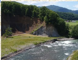
土壁(ガケ崩れ)と大岩
