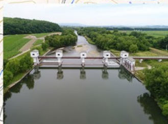
天塩川第一頭首工
