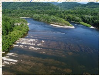
小車大橋障害物
