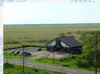
幌延ビジターセンター
